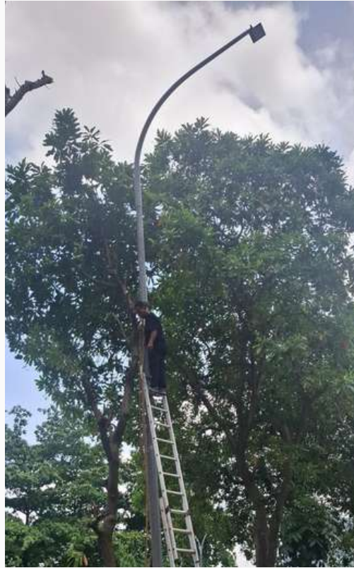
Pemotongan Tiang Lampu PJU
