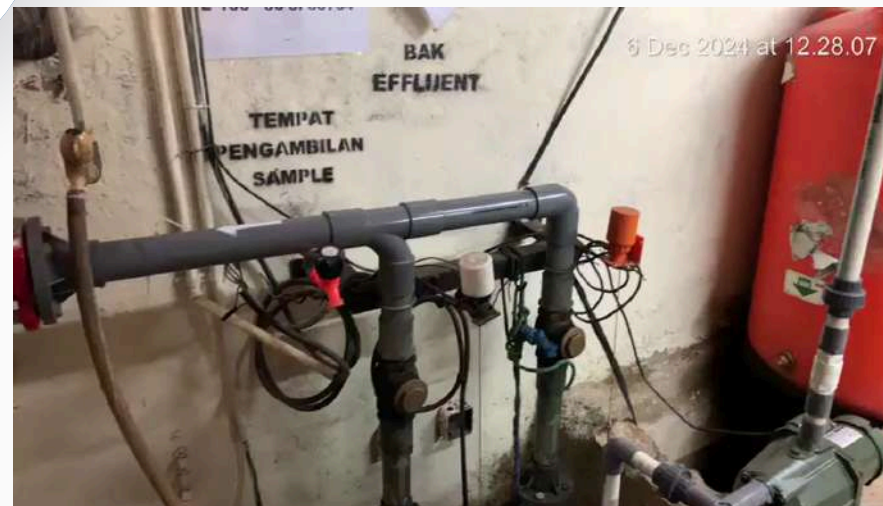
Pembuatan Instalasi Recycle STP
