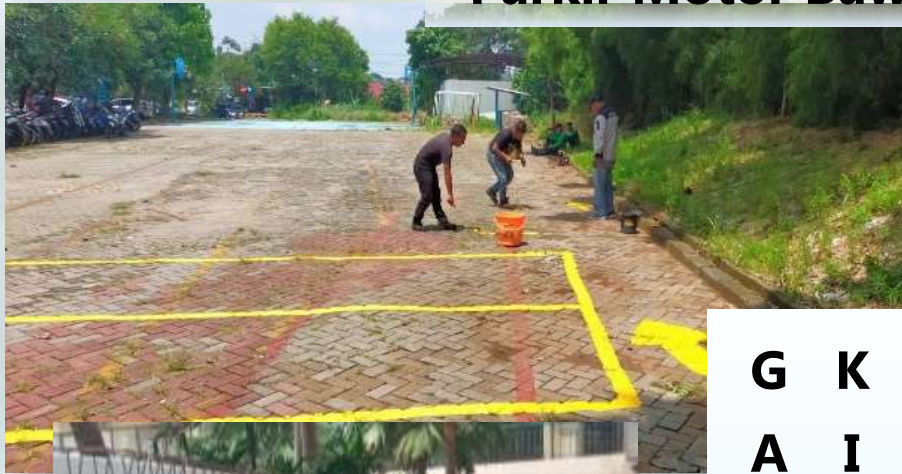
Pengecatan Lot Parkir Motor Bawah
