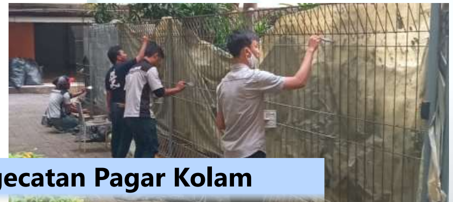
Pembuatan Pagar STP Tower A
